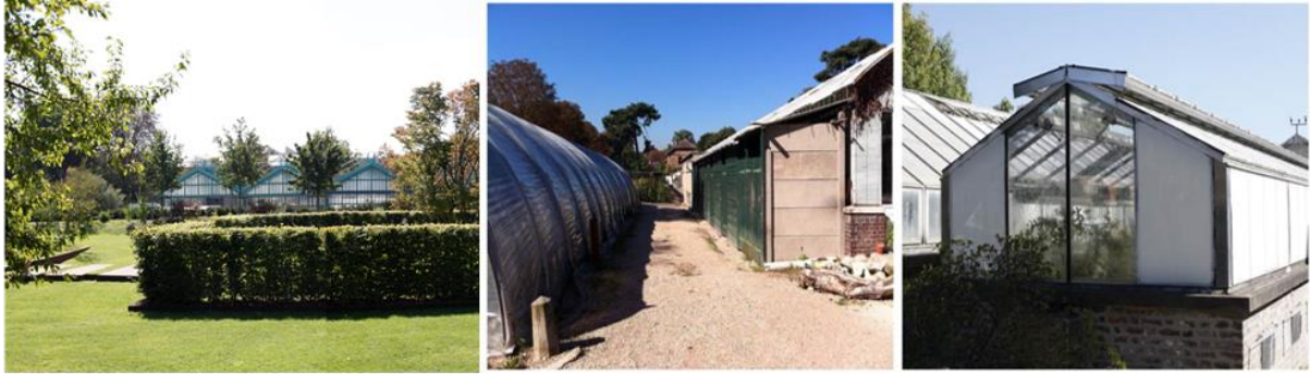
Les serres techniques et chaudes du Jardin des Serres d'Auteuil aujourd'hui
